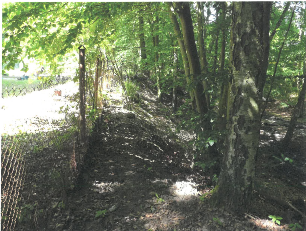
Fot. 4. Górna krawędź osuwiska dochodząca do ogrodzenia.
